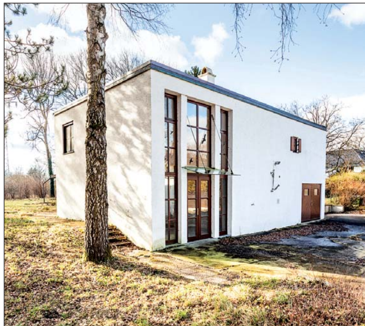
Wohnhaus in München, Heppstraße 11 Limit € 2.000.000 Erlös. € 2.755.000
