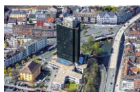
Hochhaus in zentraler Innenstadtlage in Hagen/Westfalen, Pos. 5
