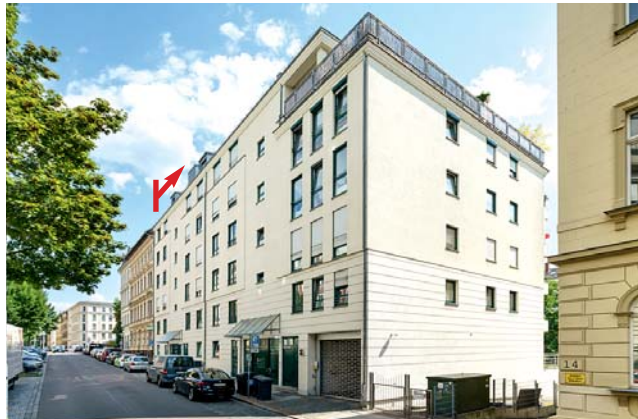
2 Mehrfamilienhäuser Leipzig ST Südvorstadt, Schenkendorfstraße 16, 16 a Limit € 4.750.000 Erlös. € 6.160.000
