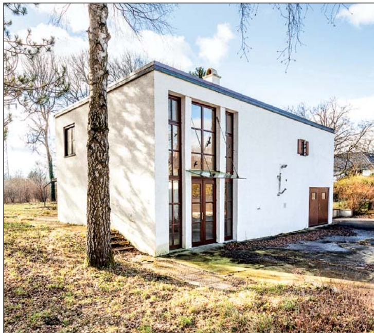
Wohnhaus in München, Heppstraße 11 Limit € 2.000.000 Erlös. € 2.755.000
